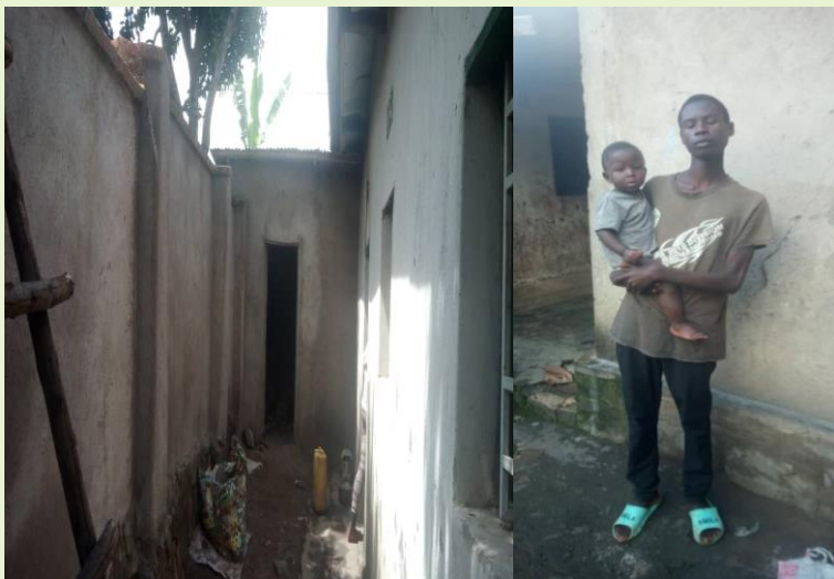
Foto: Verbeteringen aan het huis van Bertrand, de muren zijn opnieuw gemetseld en de voordeur is gerepareerd.
